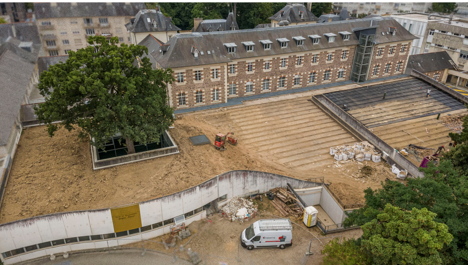
Bibliothèque en travaux, © Laurent Tacher
